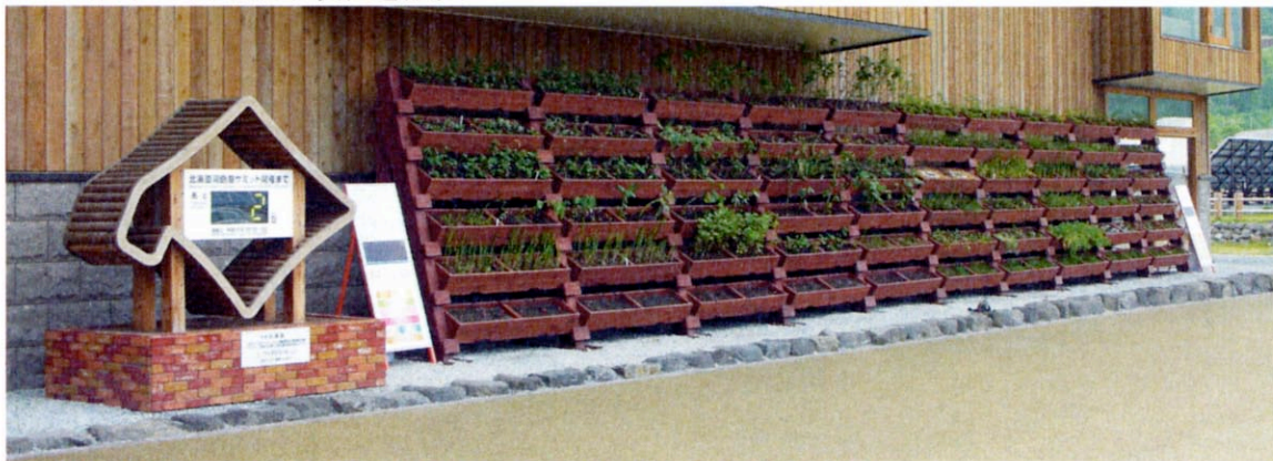
木製壁面緑化工法(写真は北海道洞爺湖サミット開催2日前 2008.07.05)
