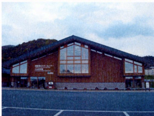
施行前の洞爺湖ビジターセンター全景
