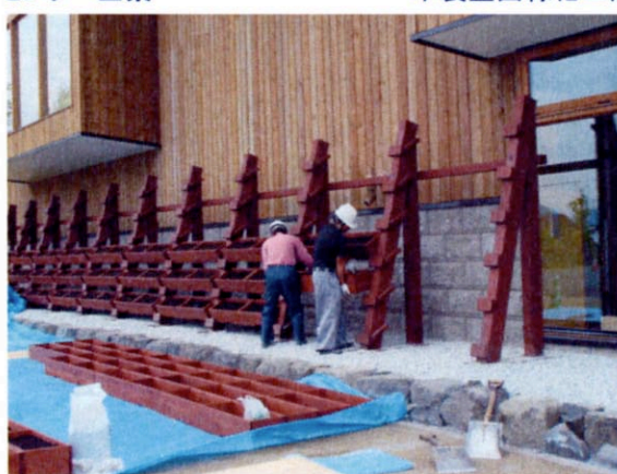
木製壁面緑化工法設置工事
