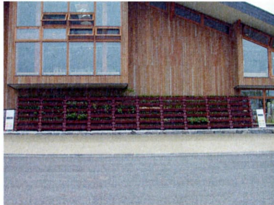
木製壁面緑化工法の完成
