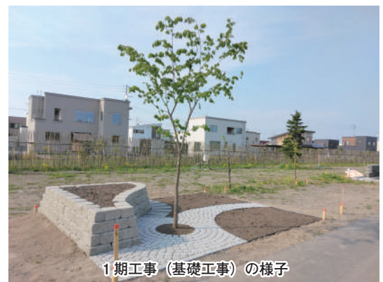
1期工事（基礎工事）の様子
